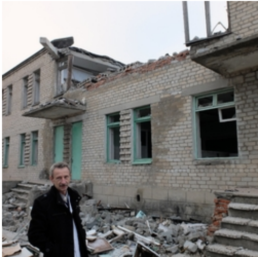
Zerstörte Klinik Switlodarsk
